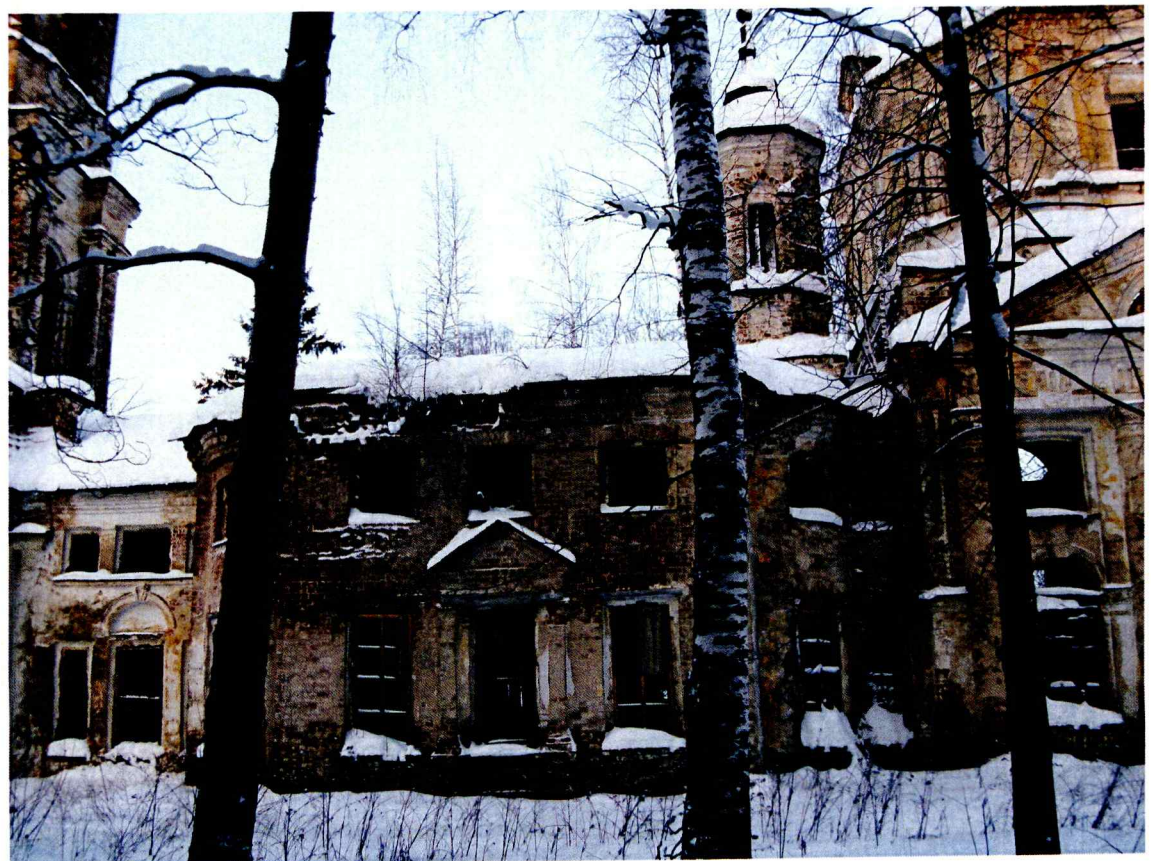
«Воскресенская церковь, 1820 г.», по адресу: Антроповский район, с. Пеньки Вид на трапезную (южный фасад)
