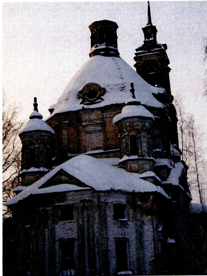
«Воскресенская церковь, 1820 г.», по адресу: Антроповский район, с. Пеньки Восточный фасад общий вид
